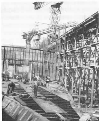
45. Klinkwerk op de dubbele bodem van het ss. 'Tjissondari', 6 mei 1914.
